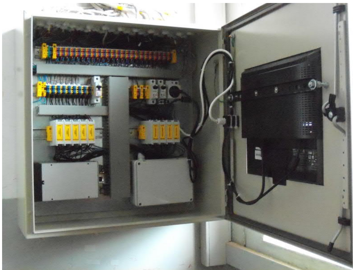
Rys. 7. – Przykładowy widok wnętrza centrali modularPAG®.
